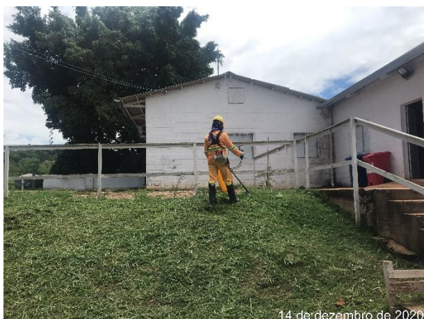
Foto 5 – Roçada do mato próximo ao canteiro (Data:14/12/2020)
